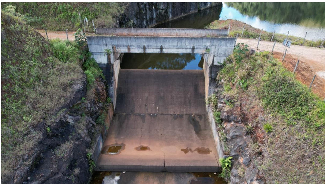
Figura 24 – Vertedouro da PCH Cachoeira da Lixa
