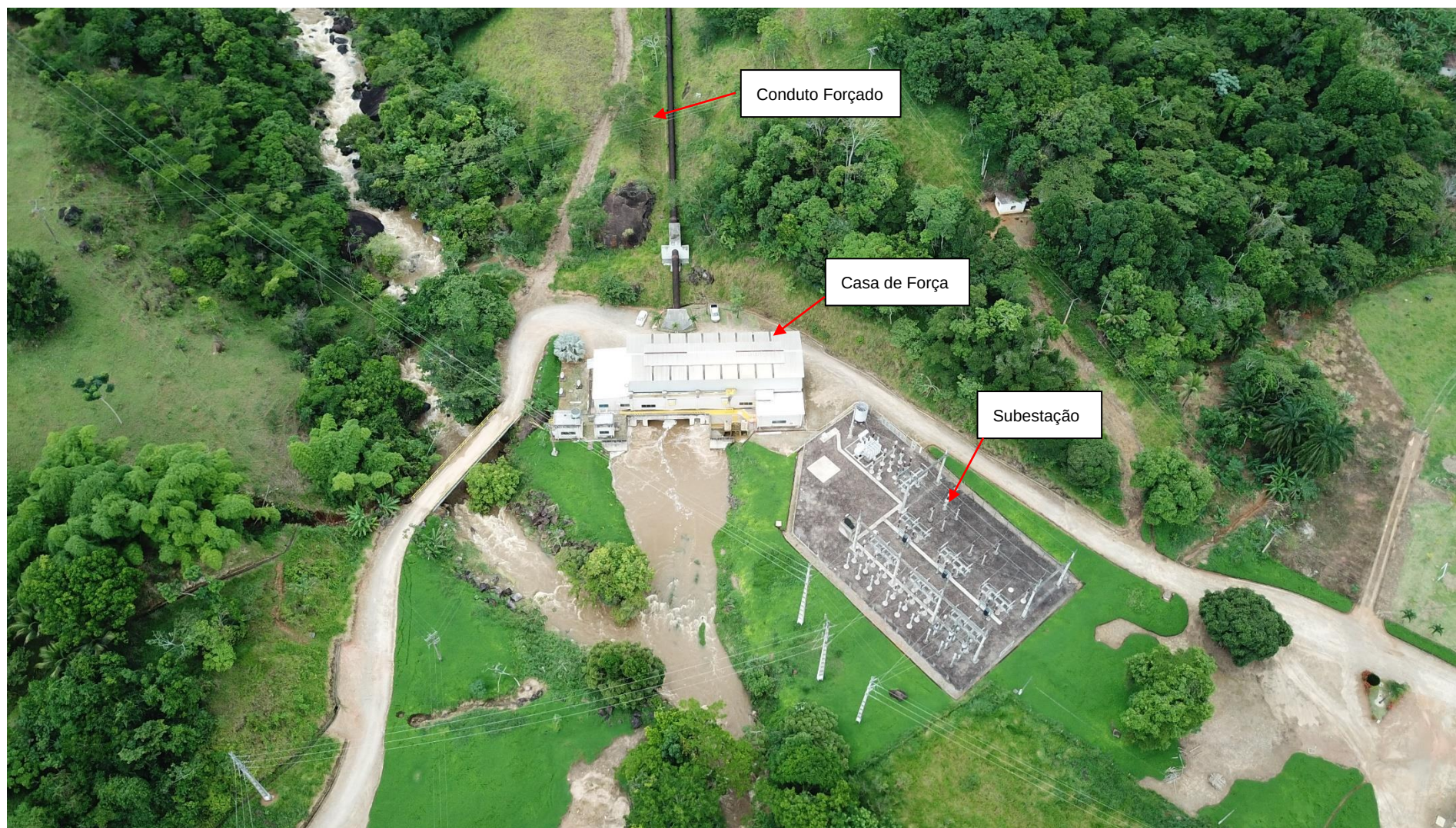
Figura 2 – Jusante da PCH Cachoeira da Lixa
