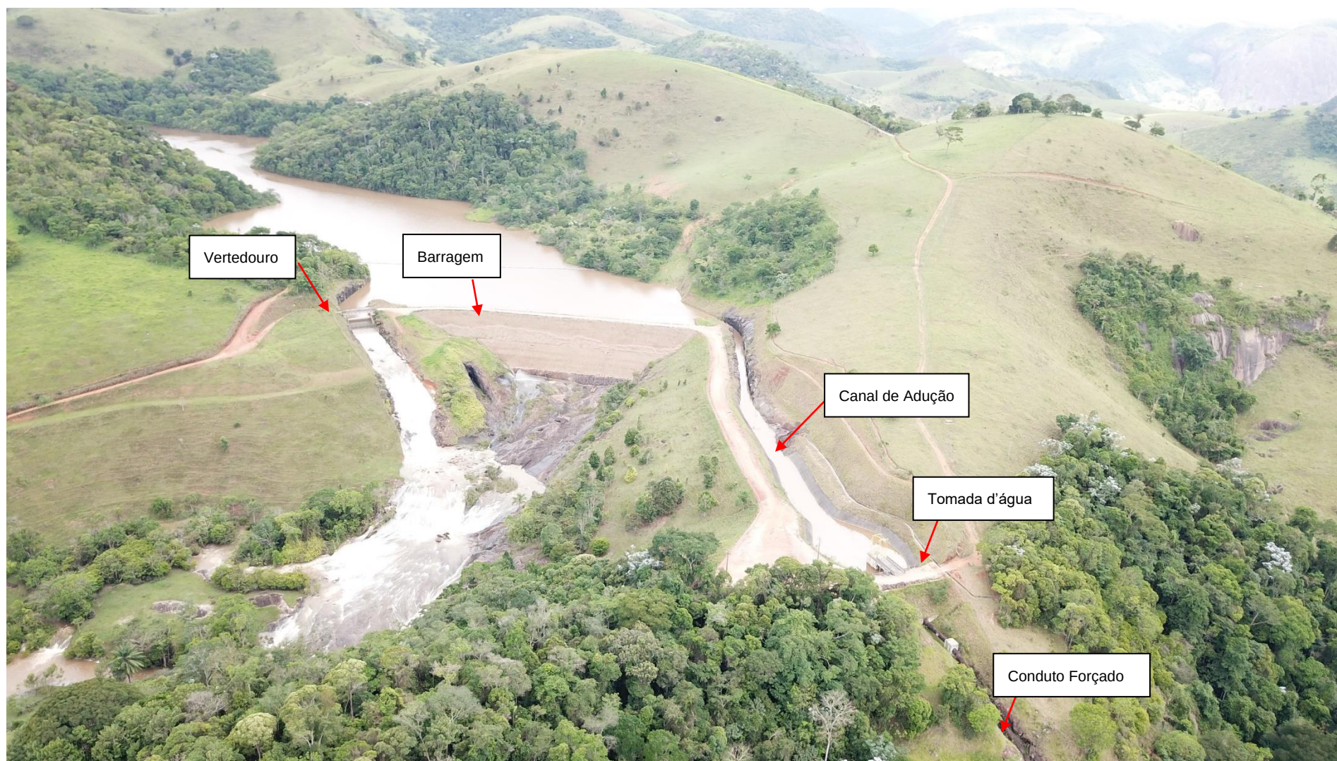
Figura 1 – Montante da PCH Cachoeira da Lixa
